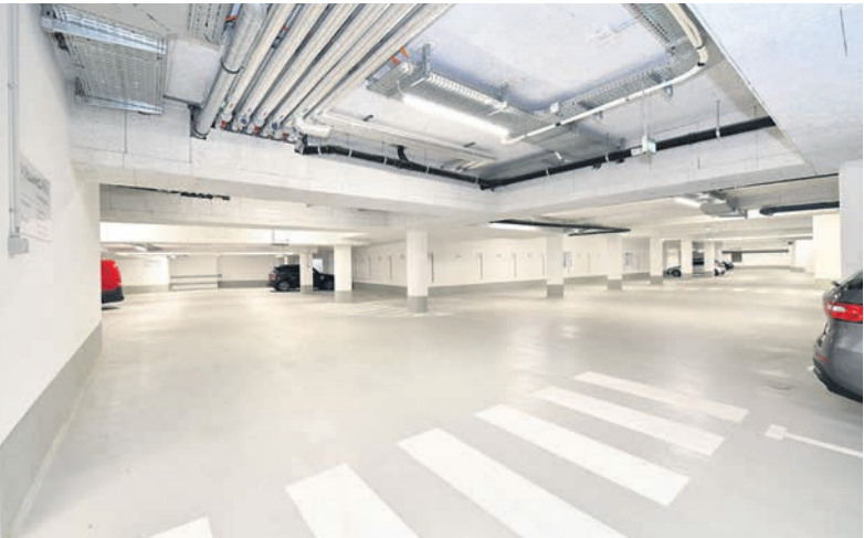
Die Tiefgarage unter den Volksbank Höfen bietet ausreichend Platz für ein „entspanntes“ Durchfahren. Von dort aus haben Besucher und Mieter einen direkten und barrierefreien Zugang zu den einzelnen Etagen.
