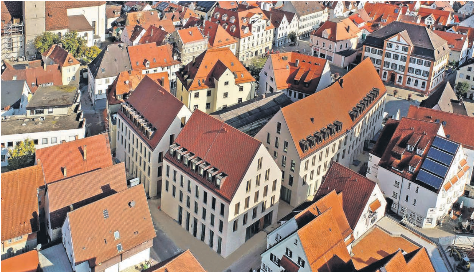
Die drei Gebäude der Volksbank Höfe bieten attraktive Gewerbeflächen und hochwertigen, bezahlbaren Wohnraum in zentraler Lage in der Ehinger Innenstadt.
